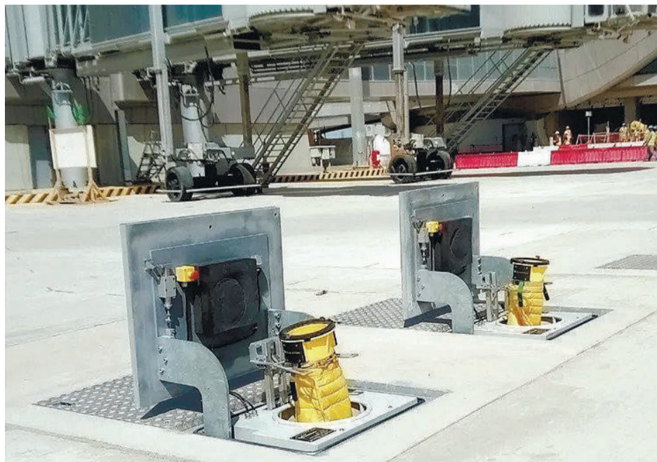
TDA- pit system פתרונות תשתיות תת רצפתית למלי תעופה - הזנה למערכות מיוזן אוויר למטוסים | צילום: באדיבות מנשה ברוך ושות' בע"מ
