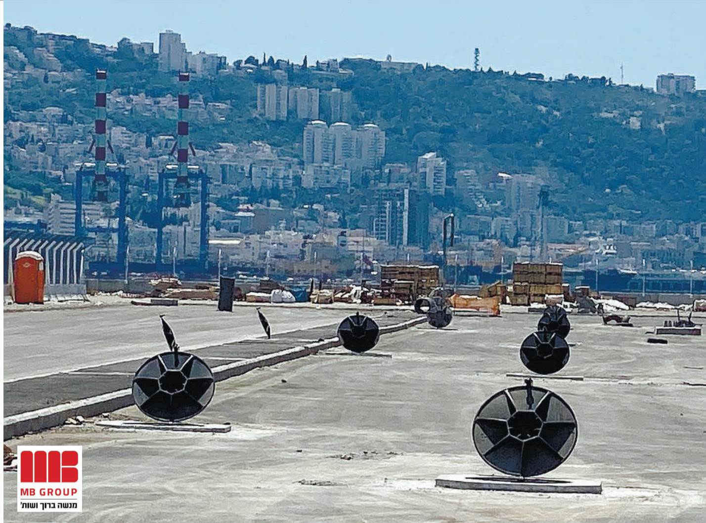
ממכסים לשוחות לעומס כבד. נמל המפרץ החדש | צילום: באדיבות מנשה ברוך ושות' בע"מ
