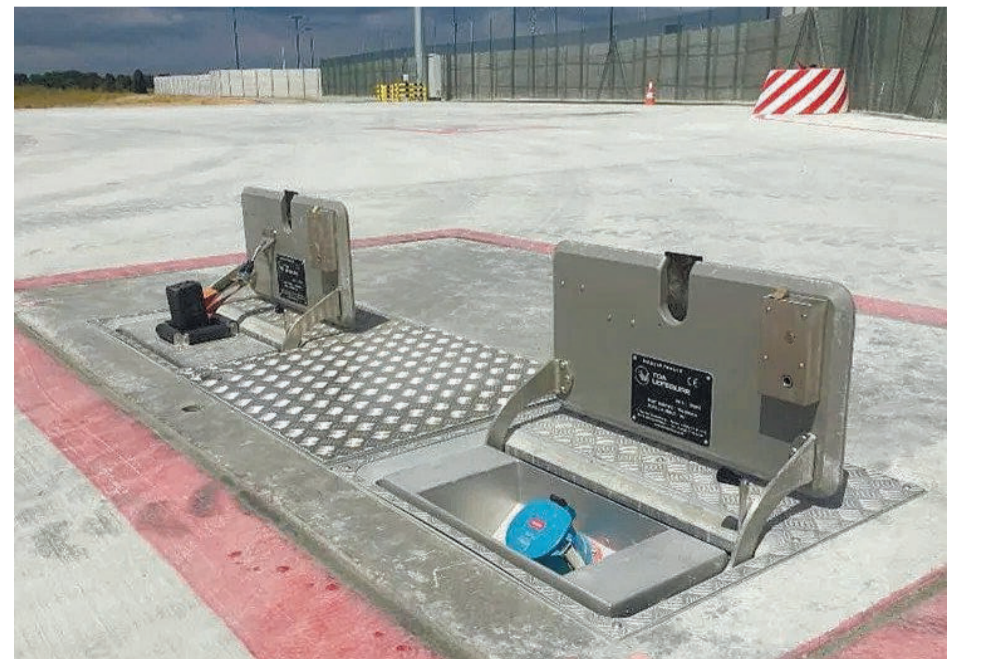
TDA- pit system פתרונות תשתיות תת רצפתית למלי תעופה - הזנת חשמל למטוסים | צילום: באדיבות מנשה ברוך ושות' בע"מ
